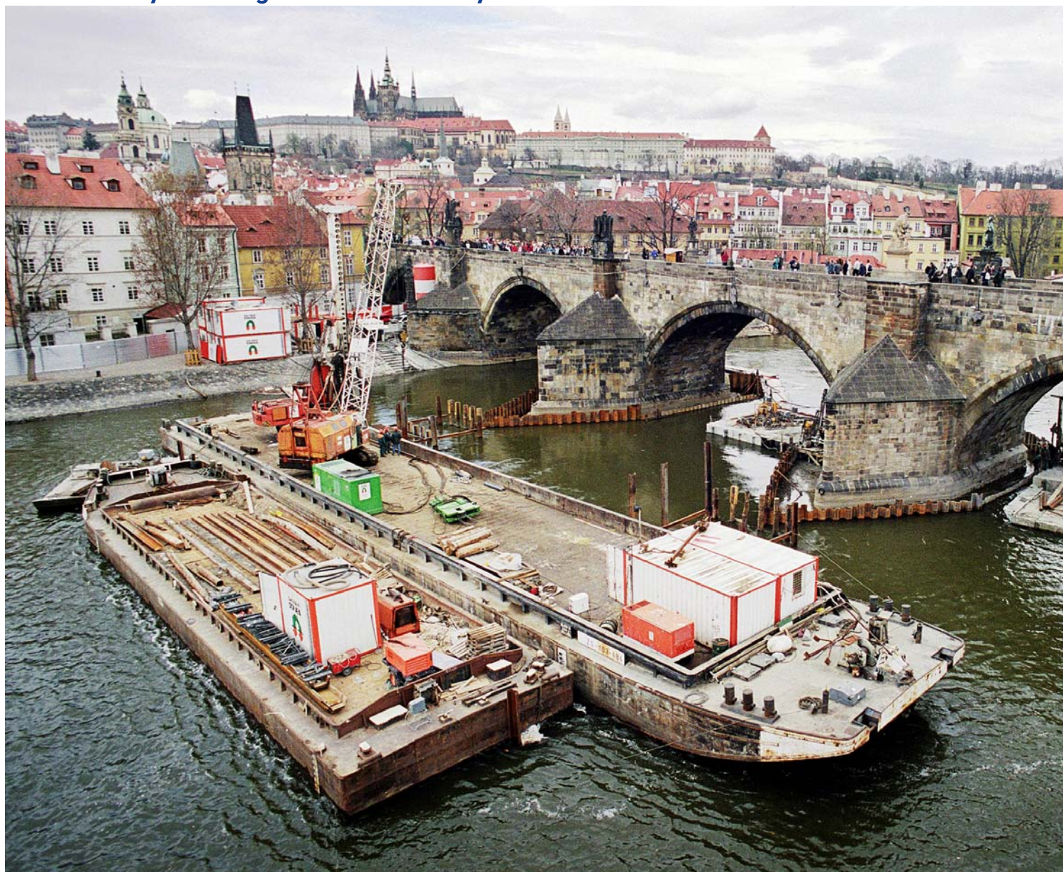
Obr. 1. Sanace pilířů Karlova mostu v Praze po povodni v roce 2002, podchytávání stávajících základů pilířů 8 a 9 pomocí sloupů tryskovými injektážemi (zdroj: Zakládání staveb, a.s.)
