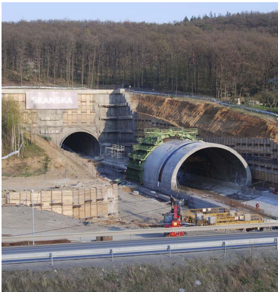
Obr. 5. Hloubený úsek tunelu Komořany na SOKP, zajištění portálové stěny výšky 28 m, kotvená pilotová stěna kombinovaná se záporovým pažením (zdroj: Zakládání staveb, a.s.)
