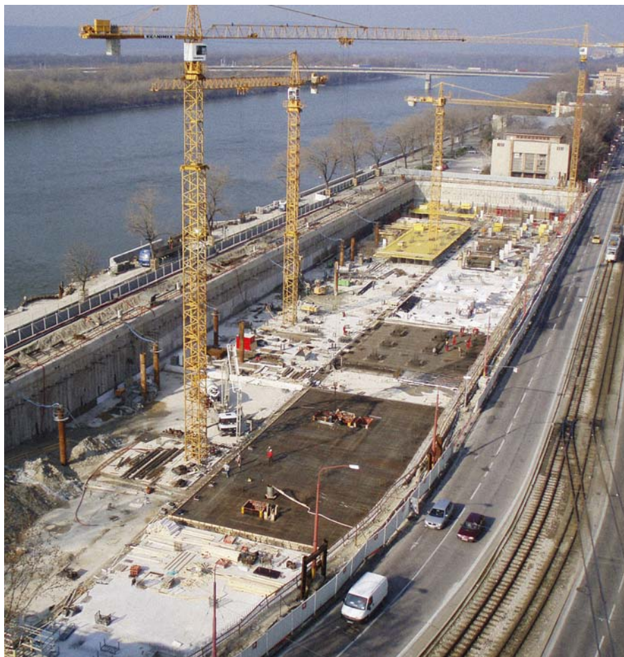
Obr. 6. Stavební jáma pro objekt River Park v Bratislavě v blízkosti Dunaje, převrtávané pilotové stěny dočasně kotvené (zdroj: Zakládání staveb, a.s.)
