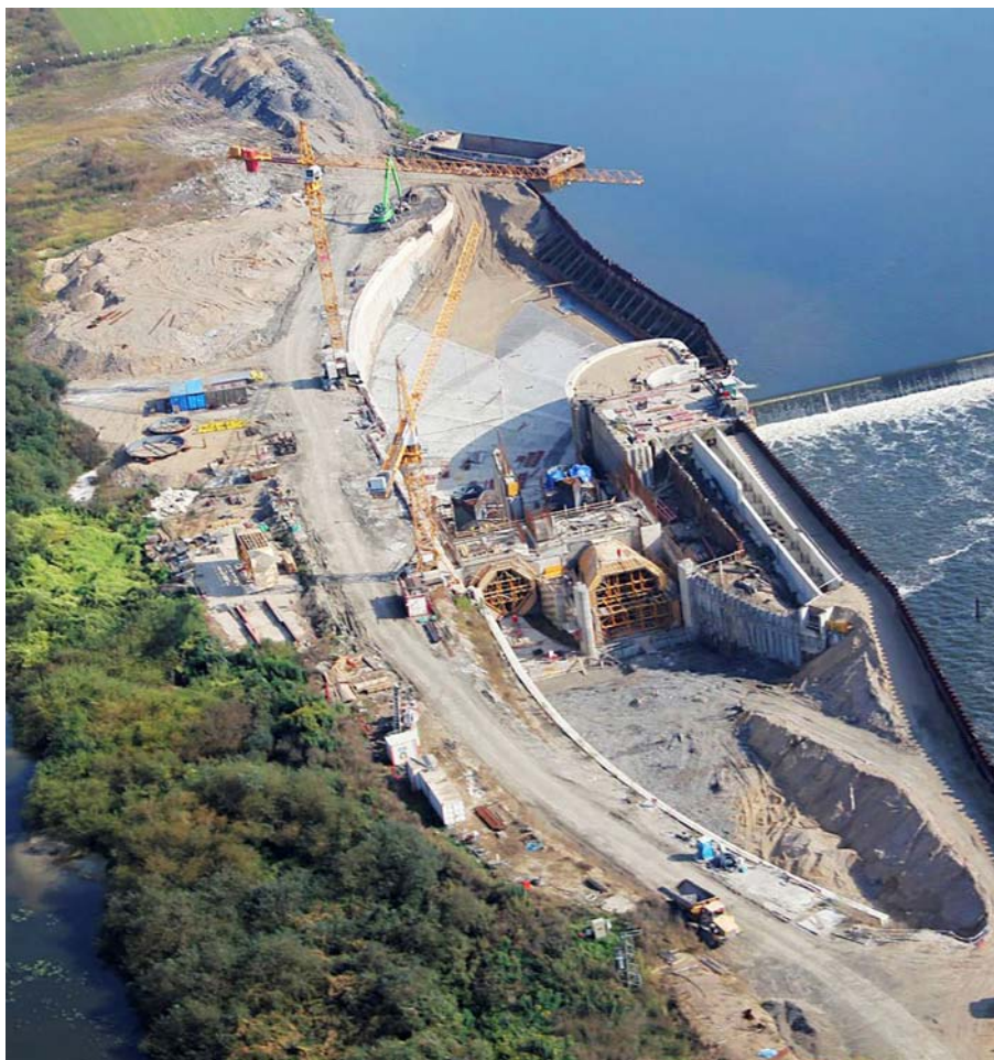
Obr. 2. Stavební jáma pro MVE Litoměřice, geotechnické riziko – tlaková podzemní voda ve dně jámy (zdroj: Zakládání staveb, a.s.)
